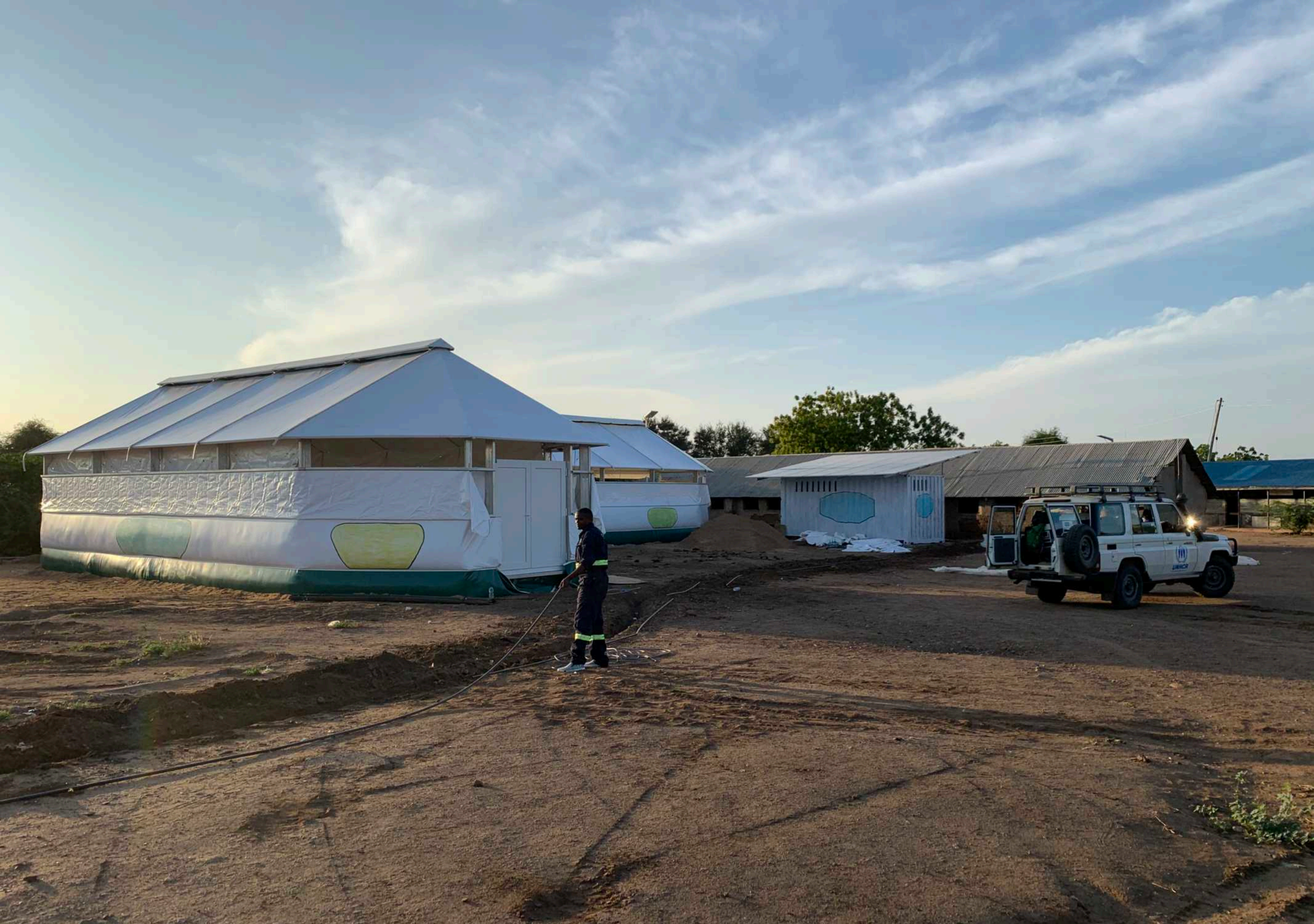
DAG 10 (15 juli): WANDZEIL LAAG 2 BUITEN
