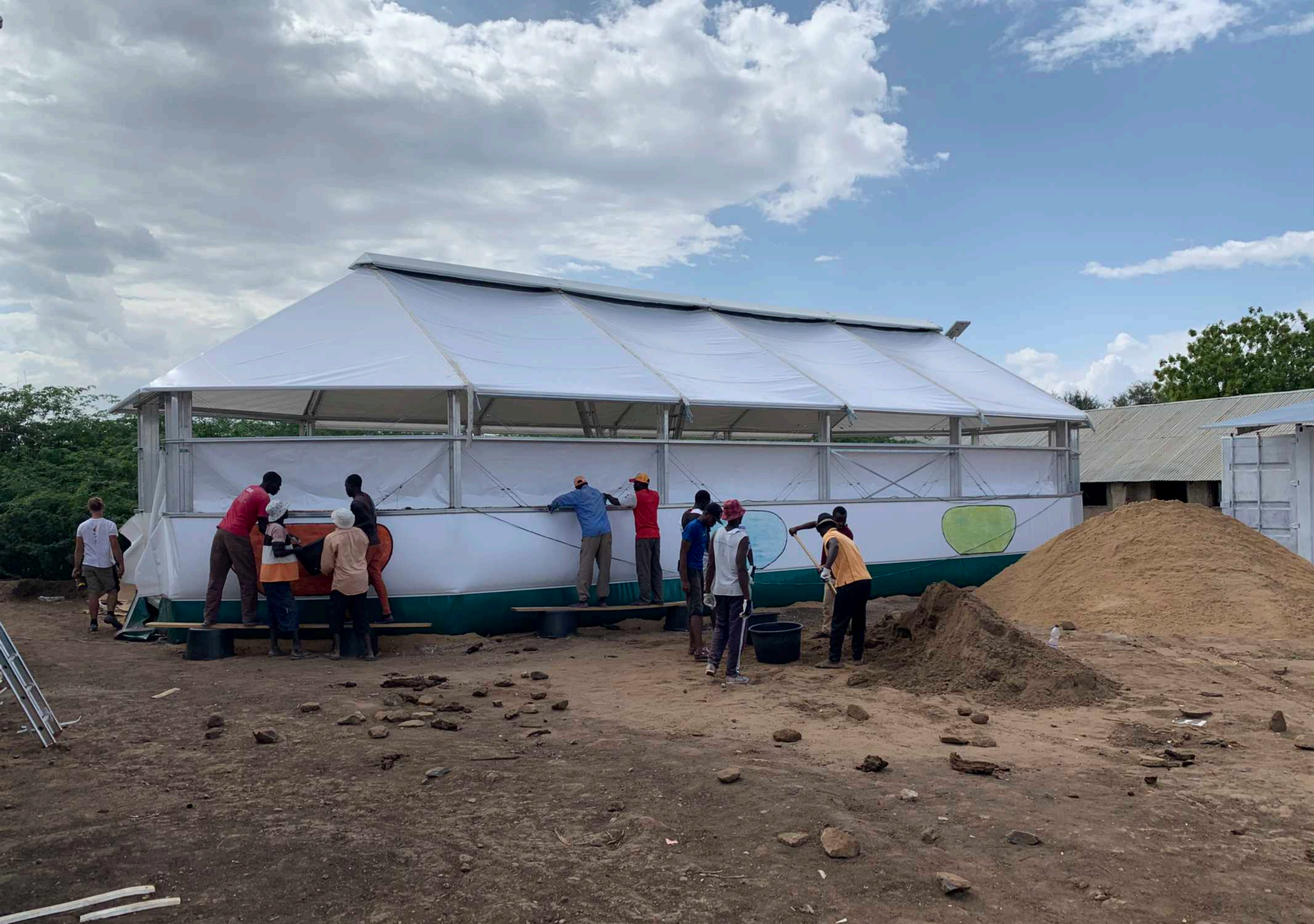
DAG 7 (12 juli): WANDZEILEN LAAG 2 BINNENZIJDE
